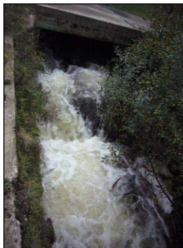
N°34 : Aval du Pont de Coma Pregona
