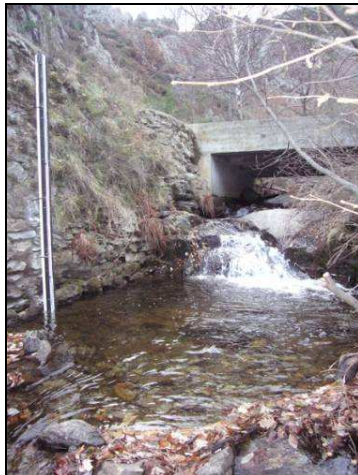
N°40 : Au niveau de la section de l'échelle (moy. eaux)
