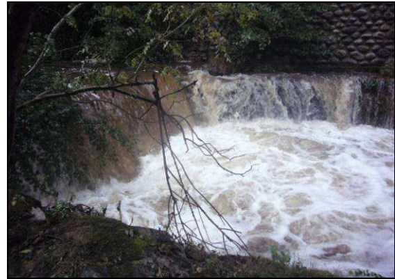
N°18 : Canal d'irrigation de Betllans
