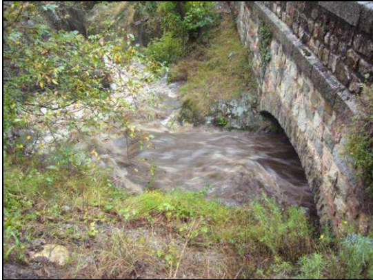
N°15 : Aval du pont de Betllans
