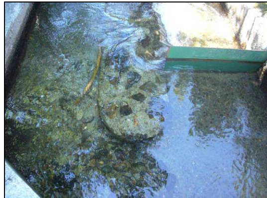
N°44 : Au niveau de la répartition
