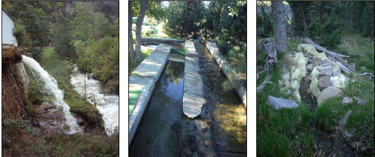
Figure 6 : Photographies (de gauche à droite) du canal de fuite de la microcentrale, du répartiteur de débit et de la dérivation de la rivière de Torrelles.
