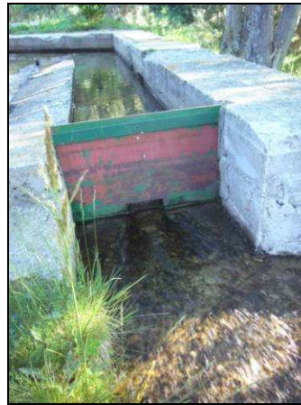
N°46 : Débit réservé alimentant Nohèdes
