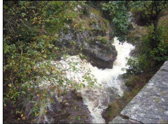
N°16 : Contrôle hydraulique en aval du pont de Betllans
