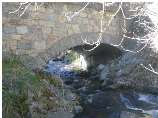
a. Ouvrage d'intérêt fort-3 (P9-645 m).
