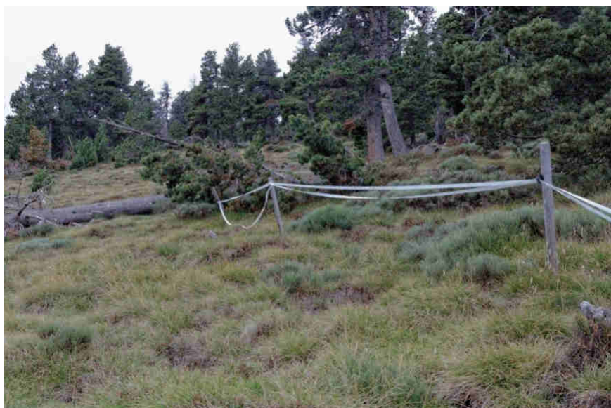
Une clôture dans un piteux état... (photo A.M.)
