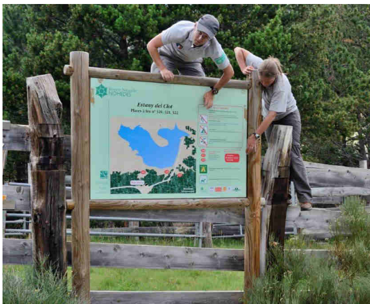
Installation du panneau « Places à feu ». (photos A. M.)
